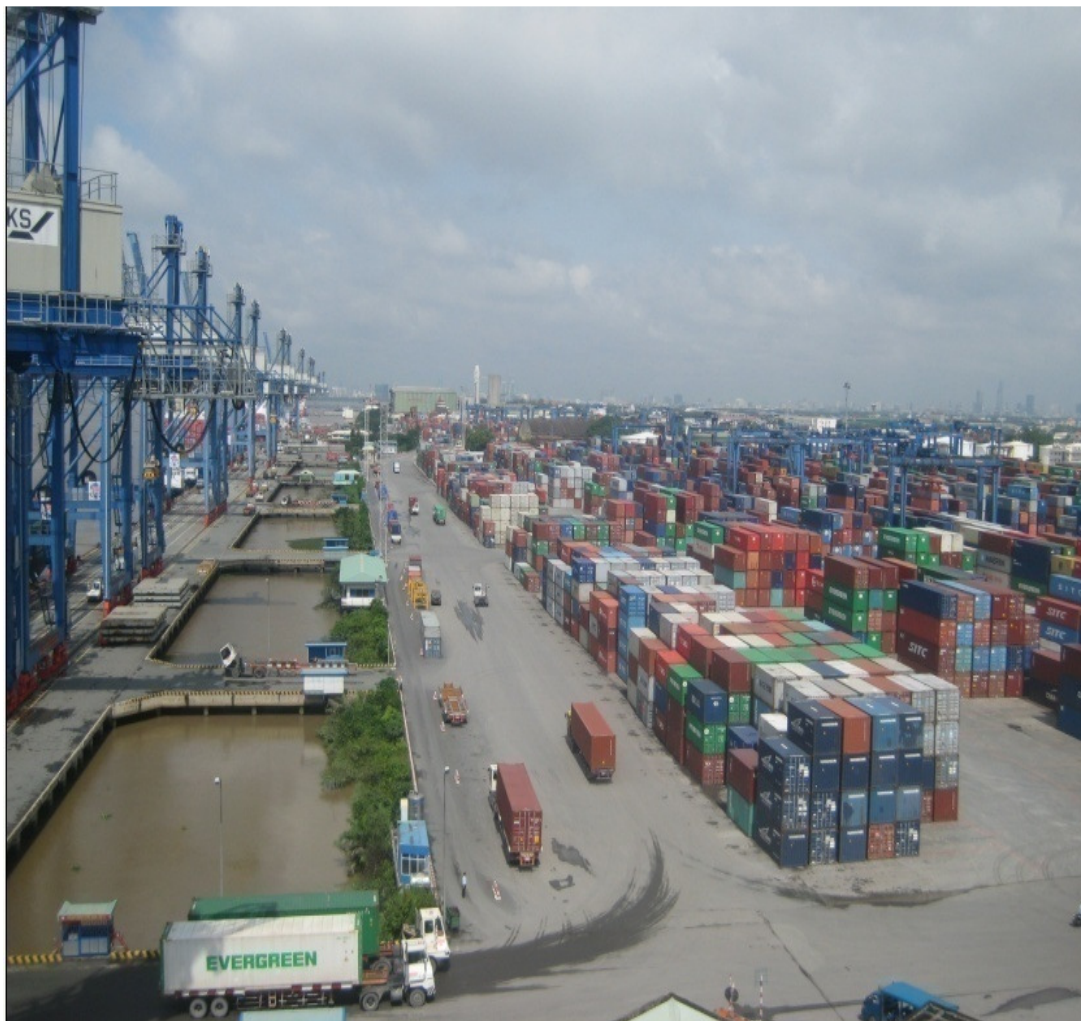
Hệ thống Bãi hàng container, đường thoát nước
